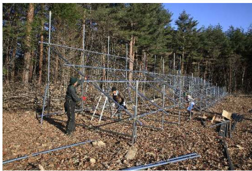
12月中旬 専門家の指導のもと架台建設工事
